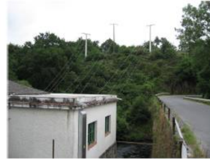
2.1- LMT Puebla (20 kV) y Central Hidroeléctrica de Valdriz, respecto al puente existente.
