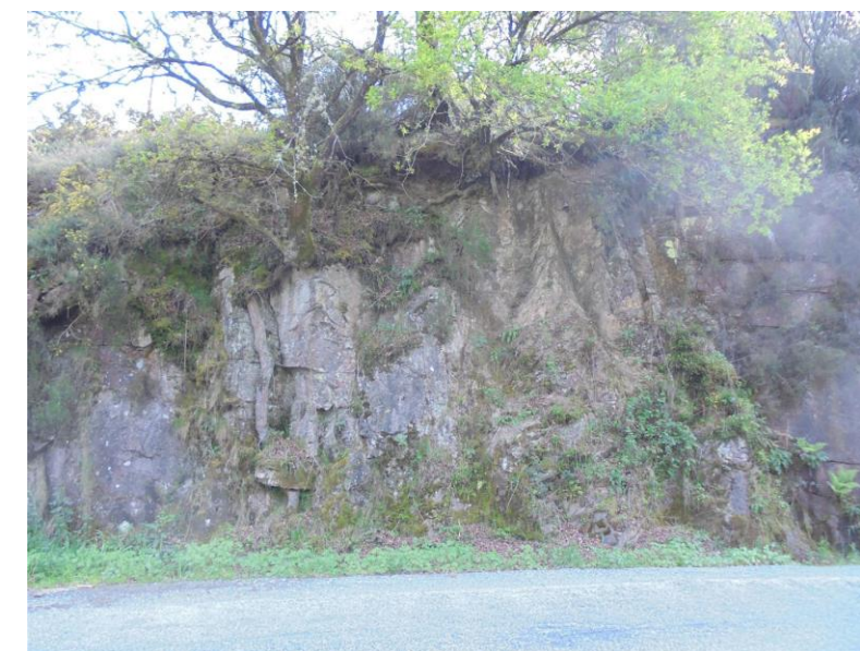
Fig. 6: Granodiorita en talud existente
